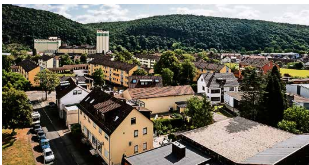
Ein Beispiel für WR Wohnraum-Projekte: Im baden-württembergischen Wertheim nahe der bayrischen Grenze hat die WR Wohnraum AG Häuser erworben, deren Sanierung gerade läuft.
